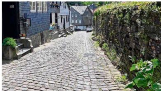
Aufgrund der unwegsamen Pflasterstrecke sind die 100 Meter bis in die Altstadt für die Bewohner des Maria-Hilf-Stifts unüberwindbar.
